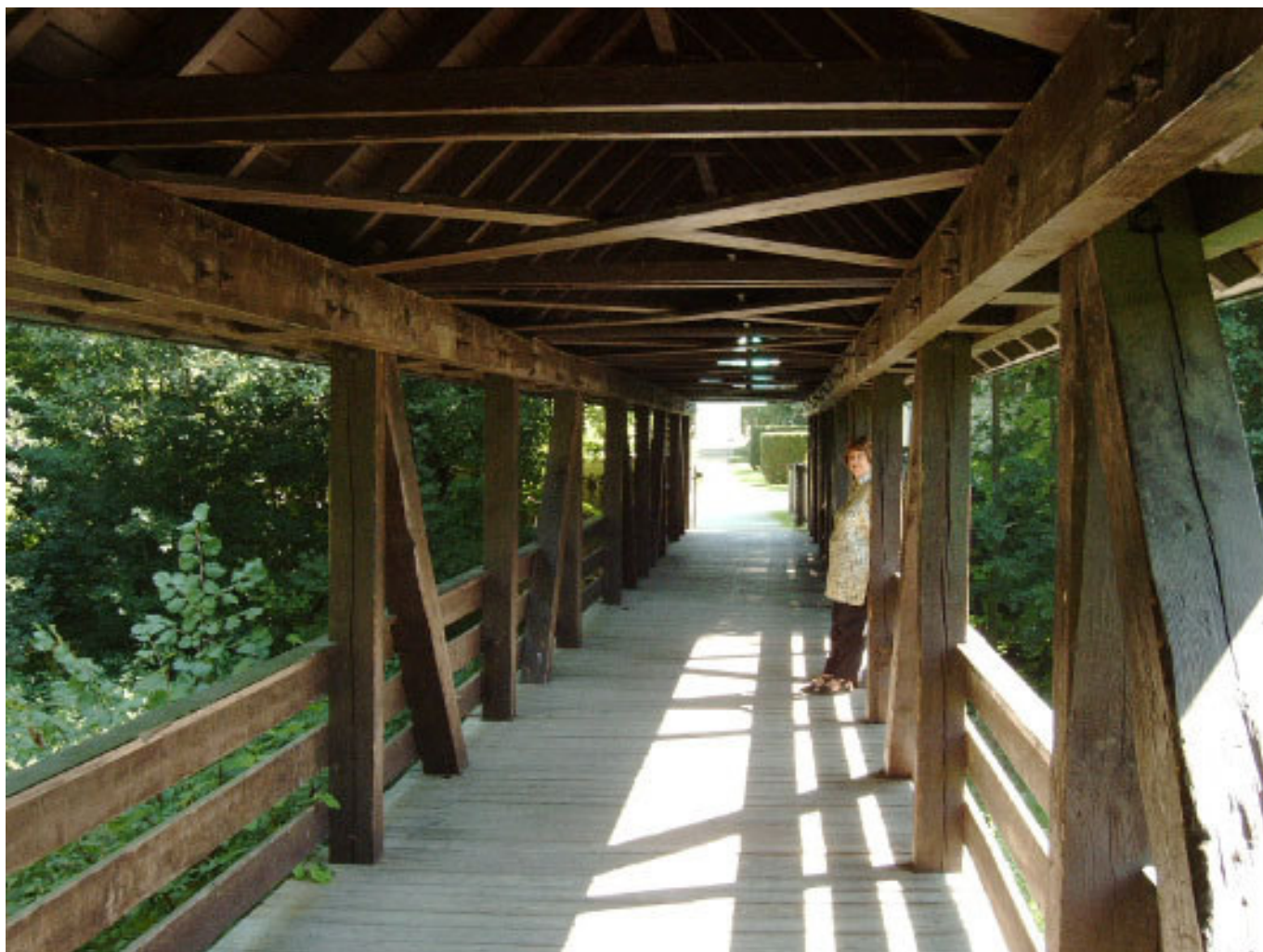
Ansicht der Fachwerk-Konstruktion der Holzbrücke über die Würm (Foto: A. Thurner 2008)
