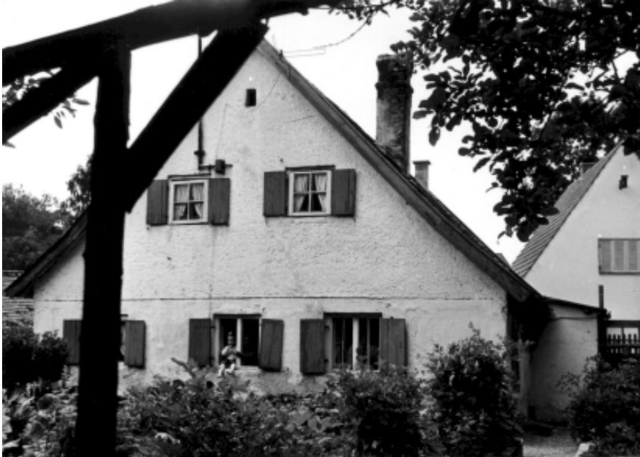
Das alte Haus im Vordergrund und der Neubau im Hintergrund, Gartenansicht von Süden im Sommer 1960 (Quelle: Fam. Fuchs)
