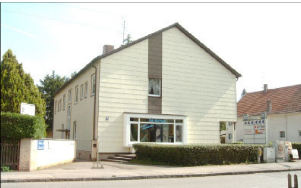
Das Wohn- und Geschäftshaus an der Eversbuschstraße 64 (Foto: A. Thurner 2008)
