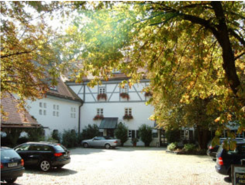
Insel-Mühle Hofansicht (von Osten) (Foto: A. Thurner 2008)
