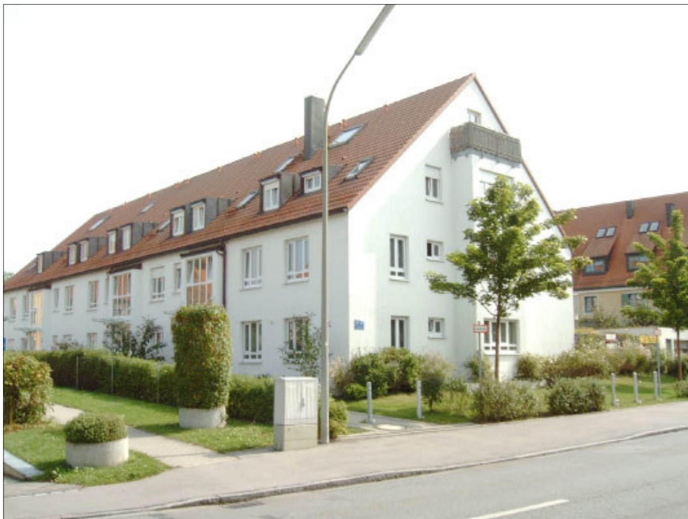
Neubau auf dem Grund des "Sternbauern" an der Eversbuschstraße 28-28c (Foto: A. Thurner 2008)
